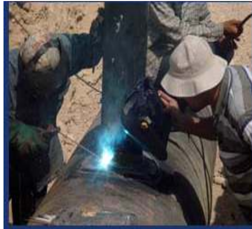
عملیات احداث خط لوله آب
